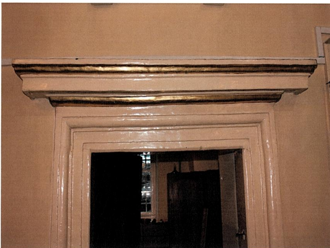
Fot. 9. Tuczepy. Kościół p.w. św. Jana Chrzciciela. Kamienny portal w przejściu z prezbiterium do zakrystii. Widoczny bardzo zły stan zachowania piaskowca spowodowane przemalowaniami farbą olejną.
