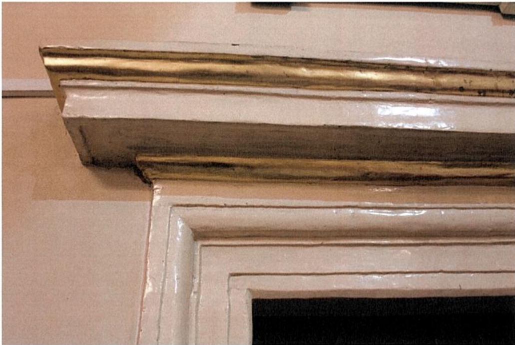
Fot 4. Portal – fragment nadproża. Zniszczenia powstałe na skutek przemalowań kamienia farbą olejną.
